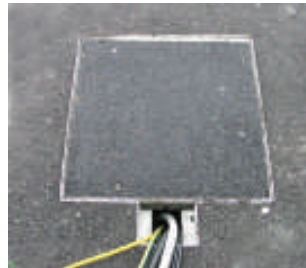
Täytä kansipinta esim. asfaltilla, sopeuta ympäristöön.
