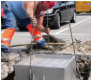
Mukauta yksikkö ja taso oikealle asennussytydelle.
