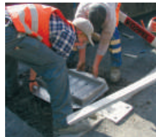
Siltakansikeskuksen asennus betonirenkaaseen.
