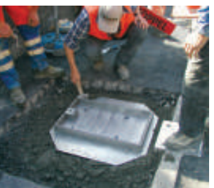
Asennusalueen tiivistys ja täyttö.
