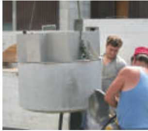
Tee kaapeliläpivientireikä betoni- renkaaseen.
