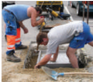
Betoni pohjan pohja.
