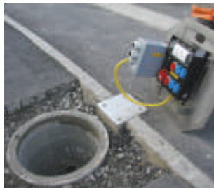
Siltakansikeskus asennusval- miina.
